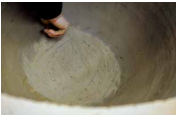
사진 152 저부 내면 점토 보강
