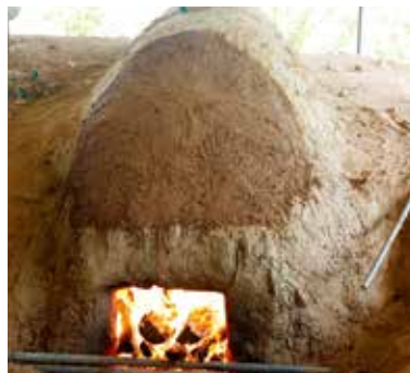
사진 223 연소부 천장 진흙 추가피복
